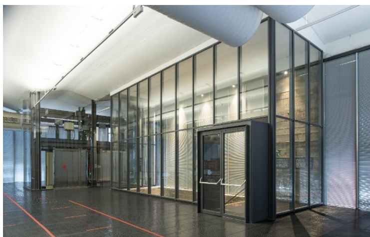
Figura 1. Compartimentação horizontal. Foto: Eduardo Ortega, 2021.
