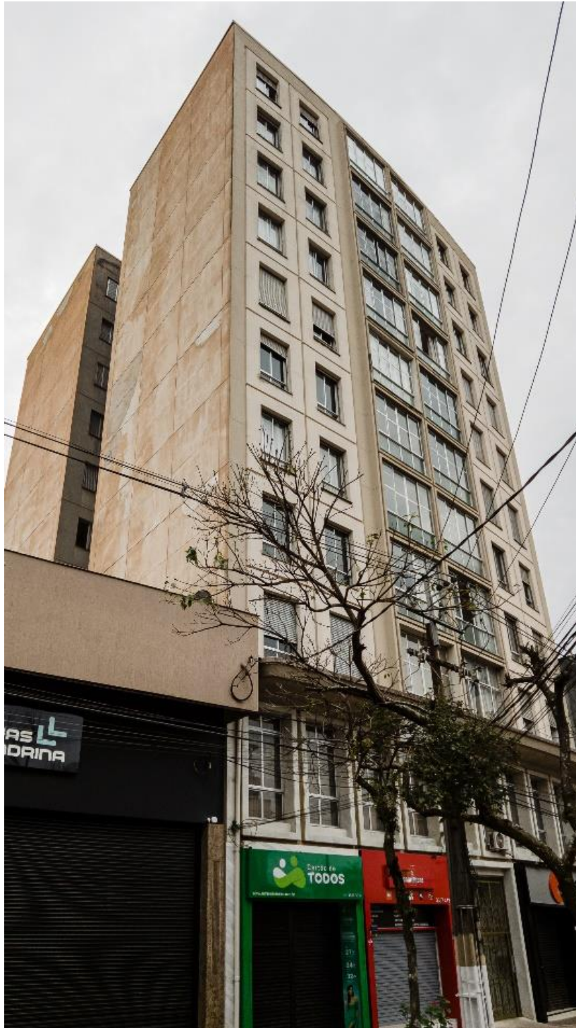
Figura 3. Edifício Santo Antônio. Fonte: Fotografia de Emy Tsutsumi, 2022.
