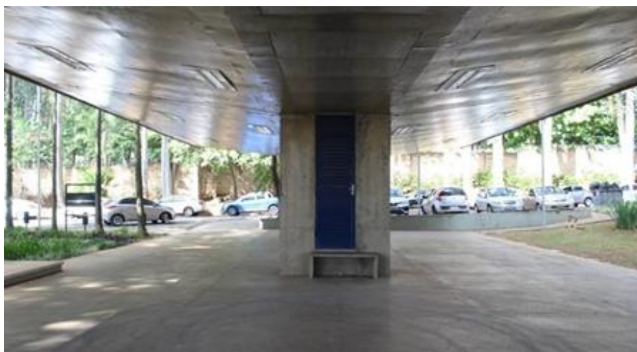
Figura 3. Pilares do E1 com porta de acesso ao sistema de dutos (shaft). Fonte: Nedel, 2018.
