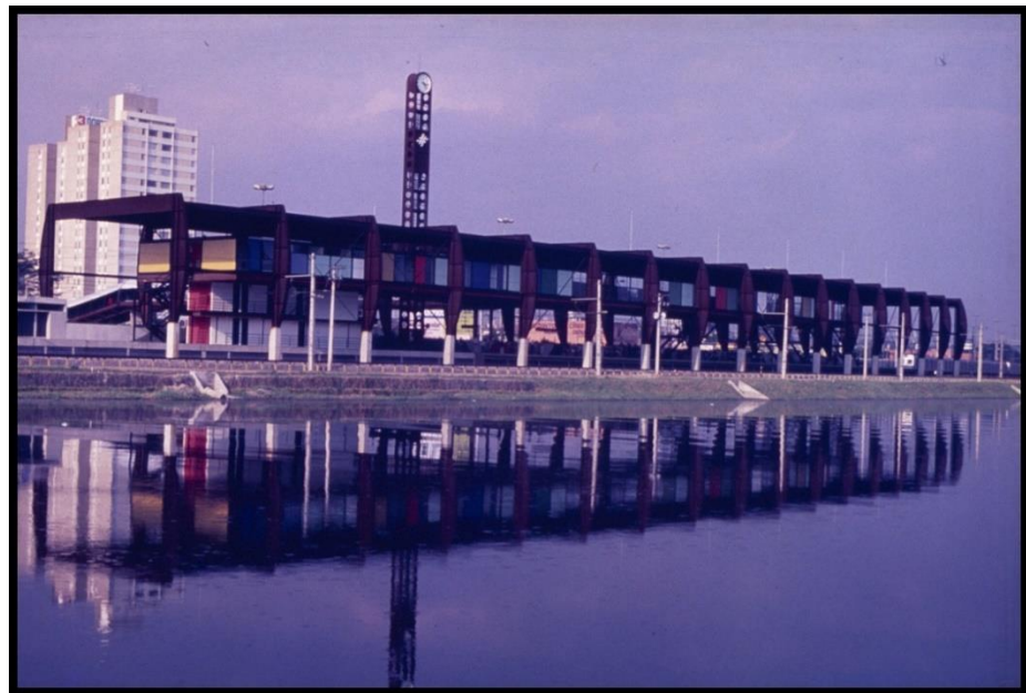
Figura 3. Estação Largo Treze de maio (1985). Disponível em: < https://www.arquigrafia.org.br/photos/7561 >. Acesso em: 22 ago 2022.
