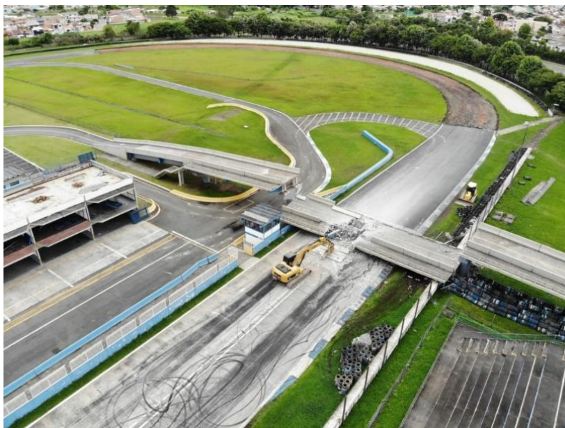
Figura 4. Imagem da demolição parcial do Autódromo Internacional do Paraná. Disponível em: https://dinheiropublico.blog.br/autodromo-de-curitiba-the-dream-is-over/ . Acesso em: 29 maio 2022.
