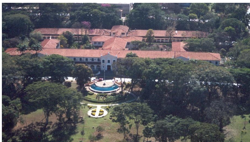
Figura 1. Prédio Central da Faculdade de Medicina de Ribeirão Preto, projetado como a sede da Escola Agrícola por Hernani Penteadó. Fonte: Faculdade de Medicina de Ribeirão Preto da USP em 2002. Foto: Acervo CCRP.
