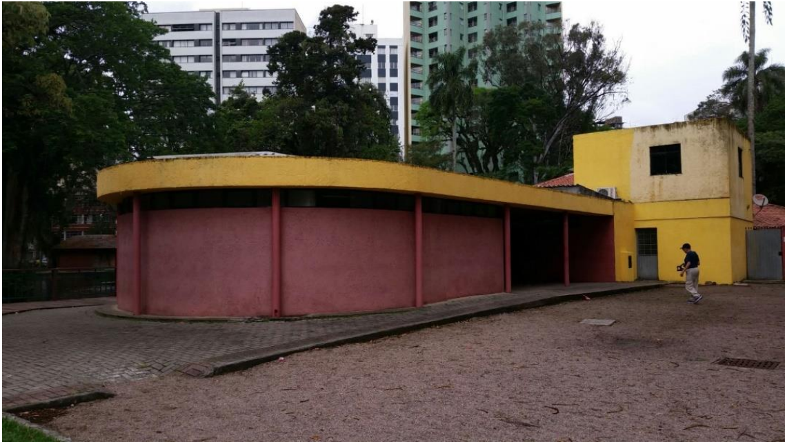
Figura 3. Imagem da estrutura do restaurante do passeio público de Curitiba que foi demolida em 2019. Fonte: Foto da autora, 2015.
