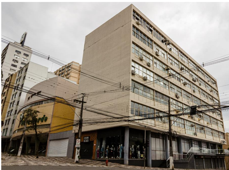
Figura 4. Edifício Autolon. Fonte: Fotografia de Emy Tsutsumi, 2022.
