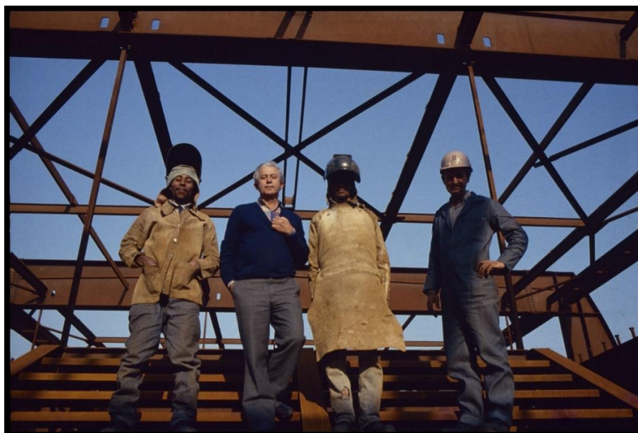
Figura 1. João Walter Toscano (suéter azul) e operários na construção da Estação Largo Treze de Maio. Disponível em: < https://www.arquigrafia.org.br/photos/7626 > Acesso em: 22 ago
