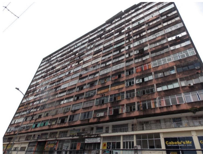
Figura 1. Fachada Av. Conde da Boa Vista – Edf Pirapama. Fonte: Liliana Adrião, 2022.
