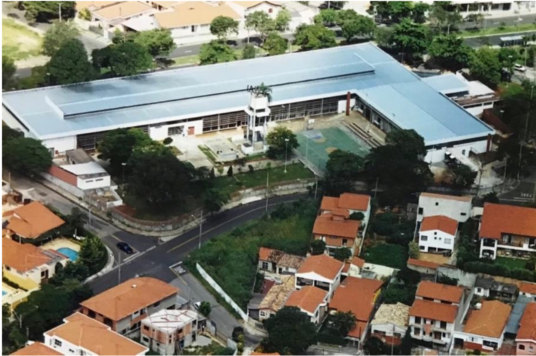
Figura 5. Imagem do acervo do SENAI, datada de 1999, mostrando a cobertura da laje em telha termoacústica.
