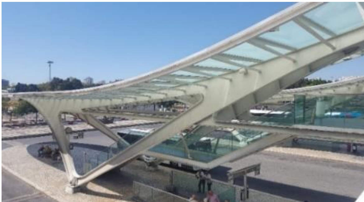
Figura 5. Imagens das estruturas de cobertura das plataformas rodoviárias. Fonte: Imagem do acervo de Miriam Castilho.
