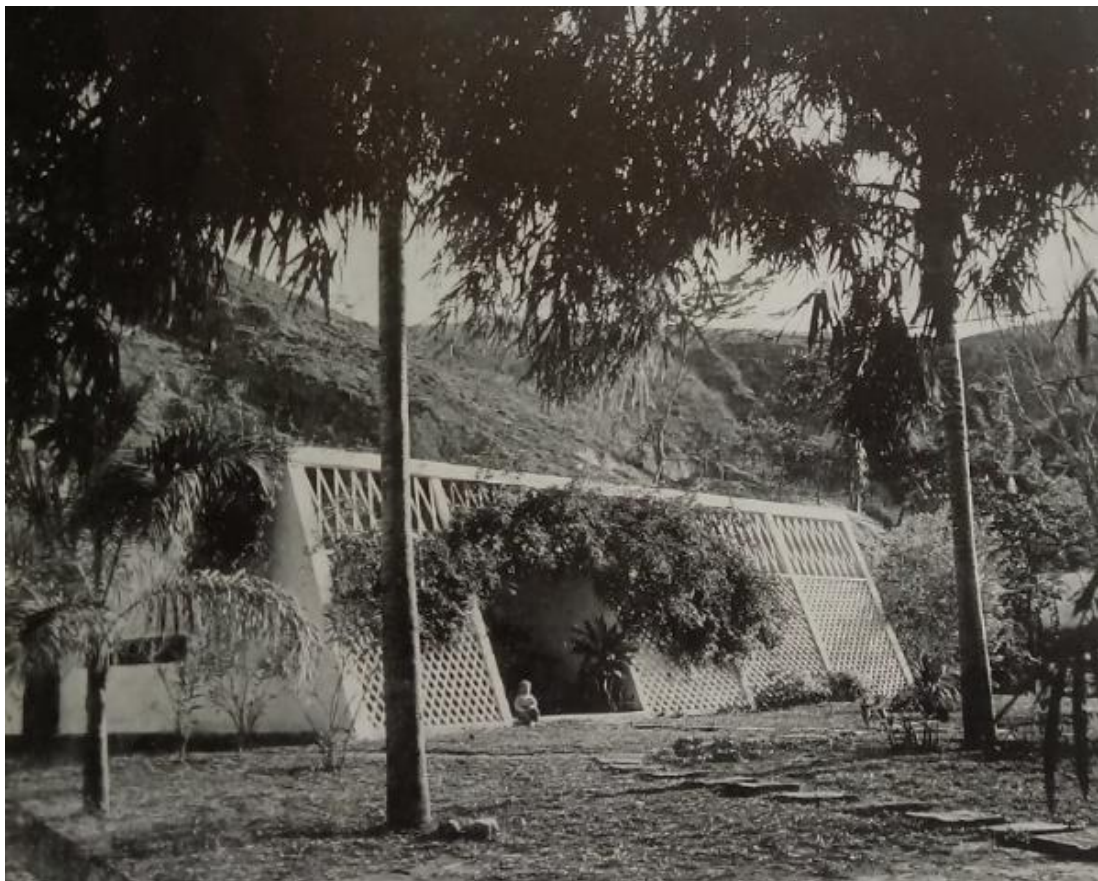
Figura 1. Casa de Mendes. Fonte: “L’Architecture d’Aujourd’hui”, número especial “Brésil”. La Maison de week-end de l’architecte a Mendes. N° 42-43, 1952, p. 78.
