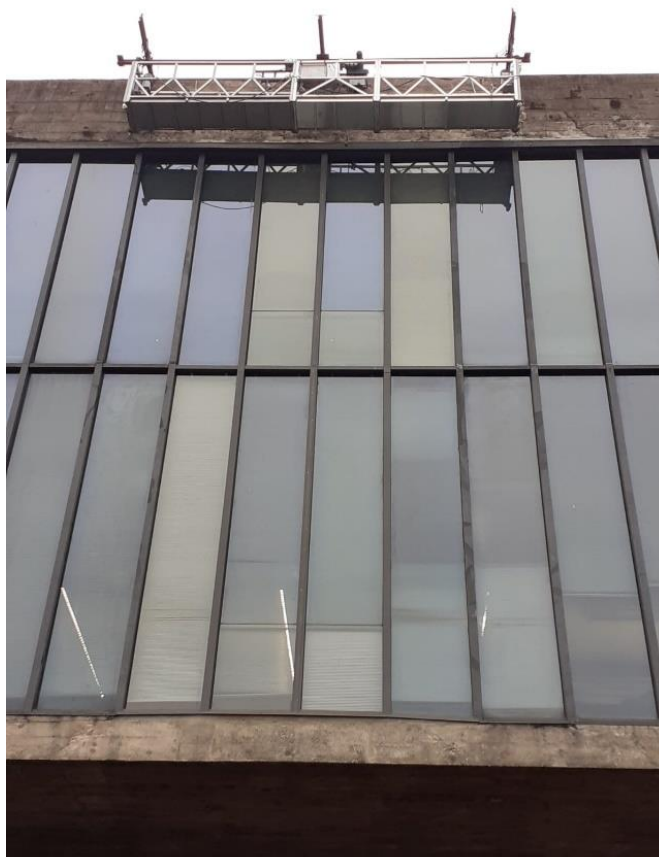
Figura 4. Fachada Carlos Comenalle com a inserção dos módulos de tombar. Foto: Miriam Elwing, 2022.
