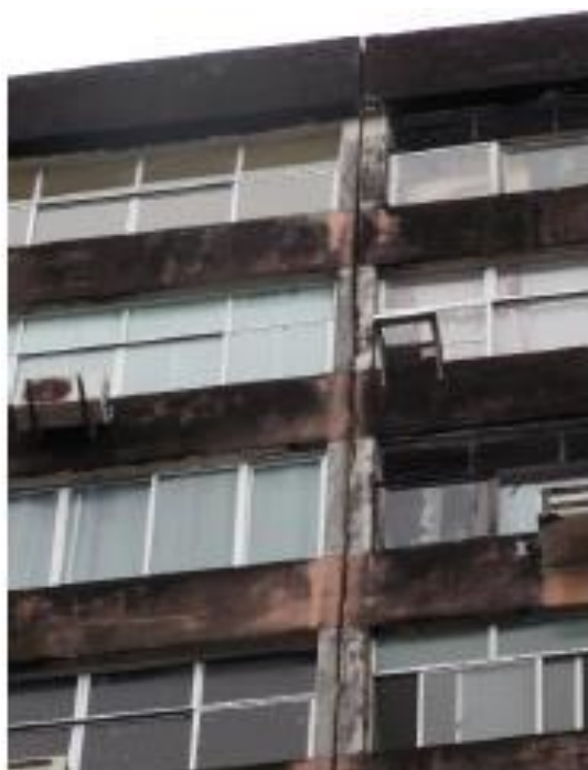
Figura 4. Fachada/Condensadores – Edf Pirapama. Fonte: Liliana Adrião, 2022.
